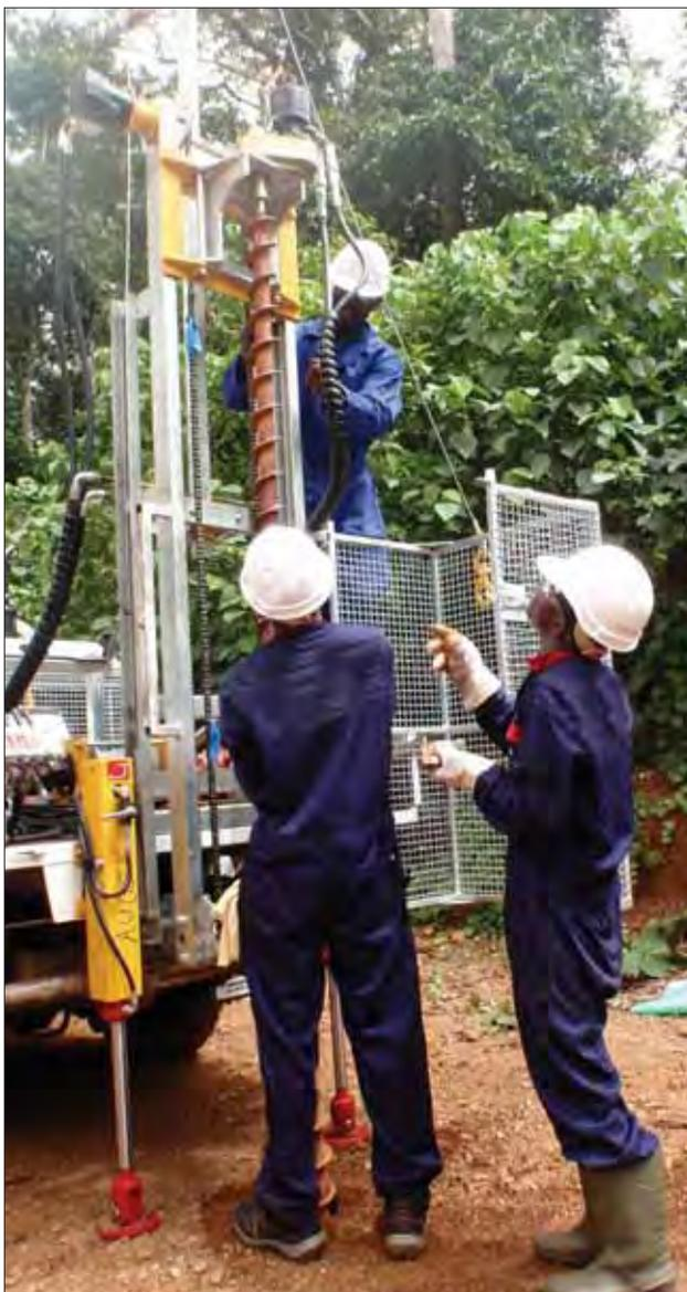
FIGURE 7: AUGER DRILLING ALONG THE RAIL ROUTE
