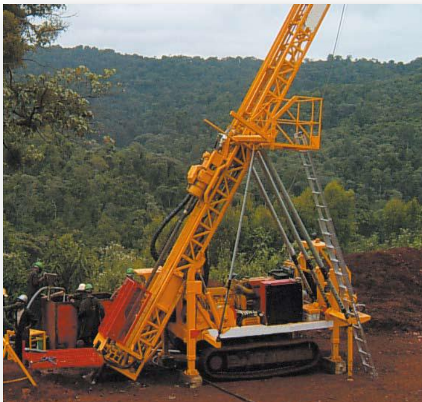
Figure 5 – Sandvik DE 710 (UDR 200D LS) Drill Rig
